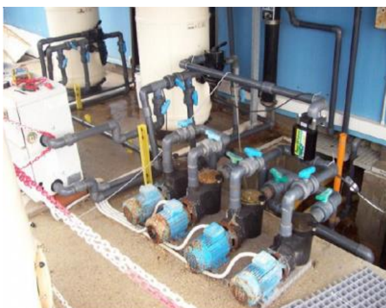
Zdjęcie z lewej przedstawia zestaw pomp zasilających wylęgarnię (zdjęcie z prawej). Urządzenie AgriFLOW 60.
