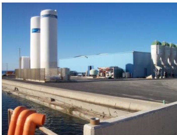
Widok obiektu hodowlanego w miejscowości Civitavecchia
