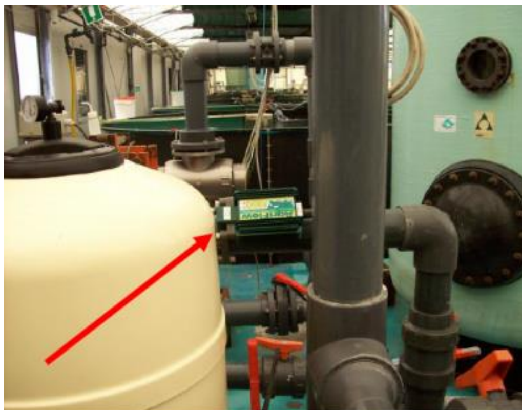
Zdjęcie przedstawia urządzenie HydroFLOW AgriFLOW 100 zamontowane na rurze zasilającej główne zbiorniki
