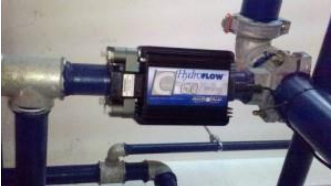
HydroFLOW C-60 na rurociągu wody zimnej.
