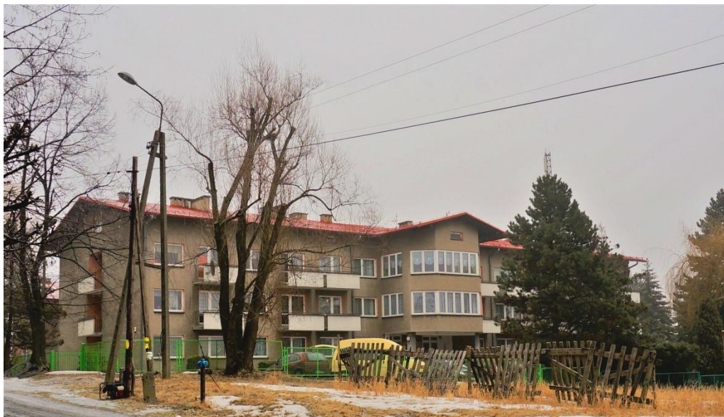
Zdj. Budynek Ewangelickiego Domu Opieki w Dziegielowie
