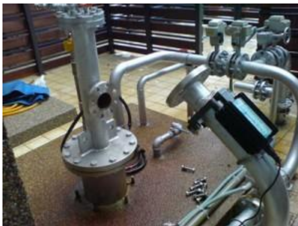
Montaż urządzeń HydroFLOW
