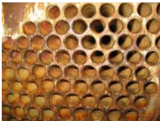
Dno sitowe wymiennika przed instalacją systemu HydroPath
