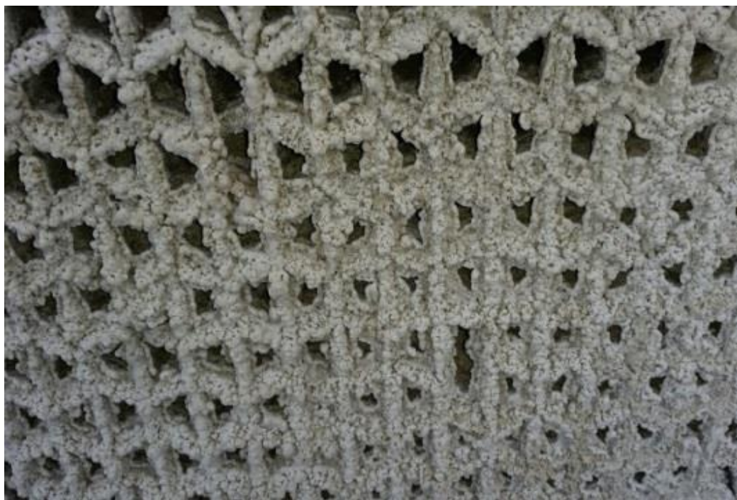
Twarde osady mineralne na lamelach wkładu wieży chłodniczej
