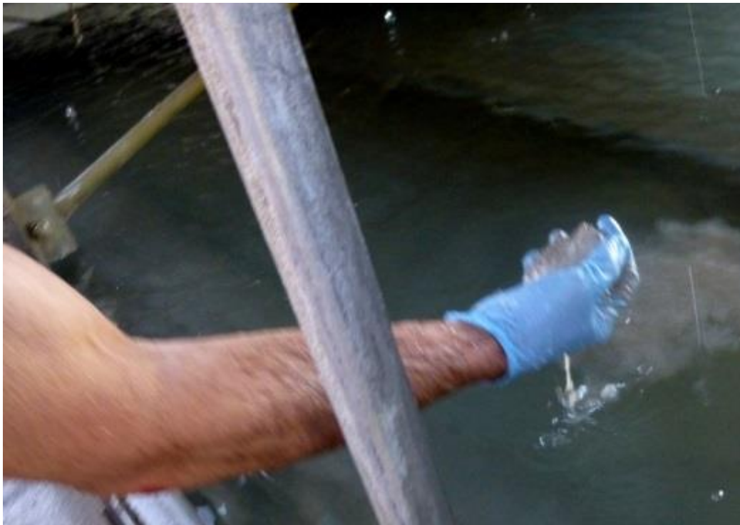
Mętna woda i muł powstały w wyniku usunięcia twardych osadów
