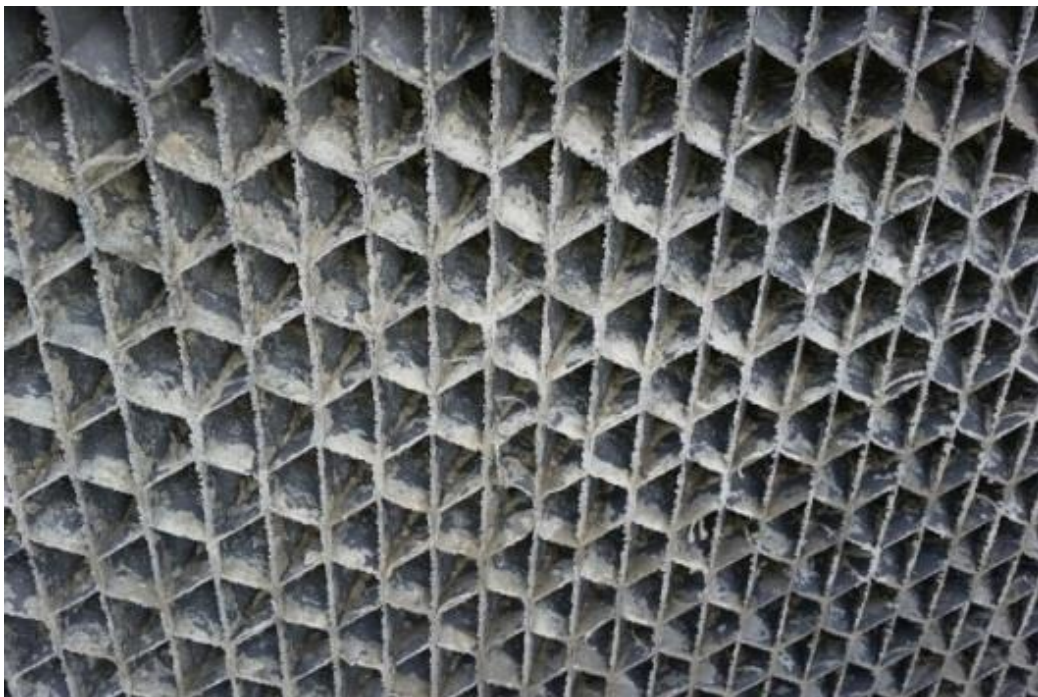
Elementy wieży chłodniczej pozbawione osadów mineralnych
